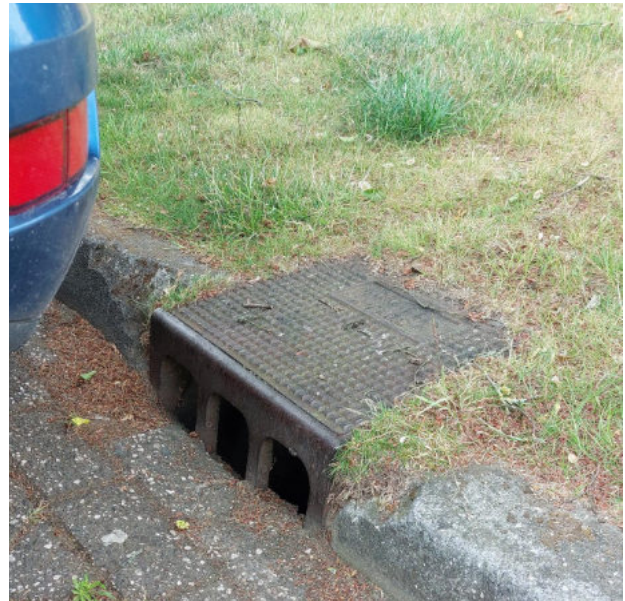
Gully am Straßenrand.
