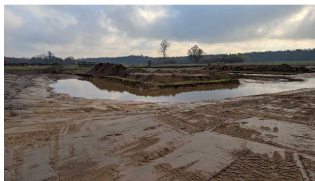
Abb. 7: Halbzeit – noch sind nicht alle Ufer geglättet. Im Hintergrund ist das abgetragene Material gut zu erkennen.
