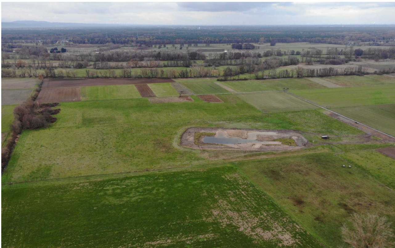
Abb. 10: Gelände nach Fertigstellung der Arbeiten.
