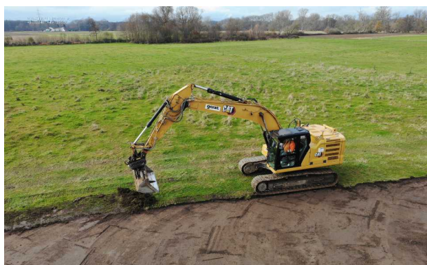
Abb. 9: Auch kleinere Abbruchkanten wurden in Detailarbeit geglättet
