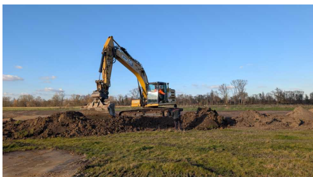
Abb. 6: Walter SCHMIDT hat ganz genaue Anweisungen an den Baggerführer
