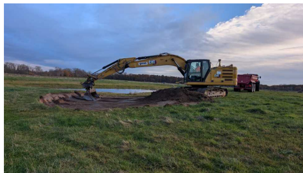
Abb. 5: Vor der Modellierung wurde viel Material abgegraben und wegtransportiert.
